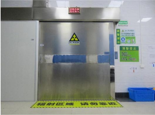
图 3-1 机房防护门及工作指示灯
