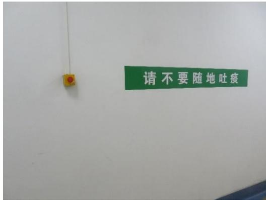
图 3-12 机房迷道入口处急停按钮
