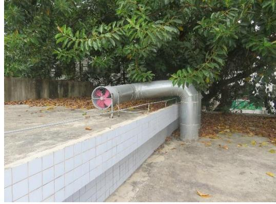
图 3-26 机房上方排风管道出口
