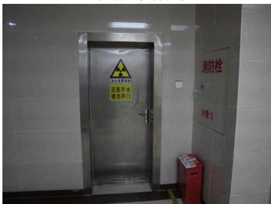
图 3-8 机房西侧防护门图
