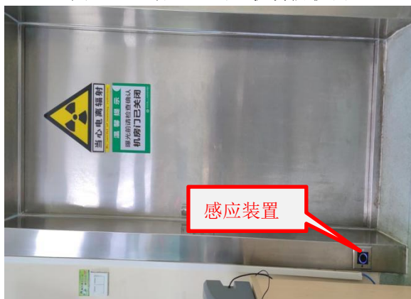
图 3-6 控制室机房防护门
